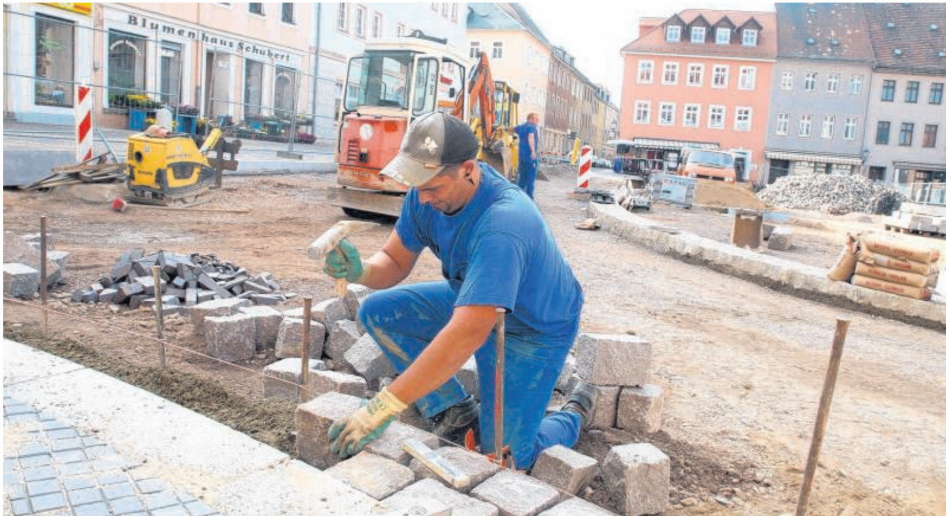
Zielstrebig setzen sich die Arbeiten am Leisniger Markt fort. Von der Muldenstraße aus kann er schon wieder befahren werden. Die Pflasterarbeiten bewegen sich derzeit vom Rathaus aufwärts in Richtung Sparkasse. Für November ist das Bauende vorgesehen. Foto: Jürgen Kulschewski
